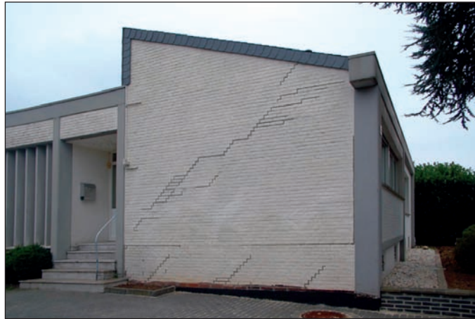
12 Schadensbild 20 m abseits des früheren Erdstufenverlaufes
