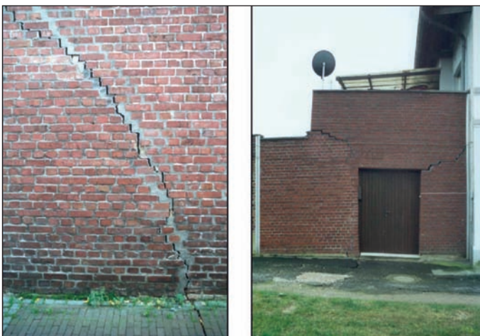
8 Neuer Riss entlang einer alten Rissnarbe und Versatz in einem Nebengebäude
